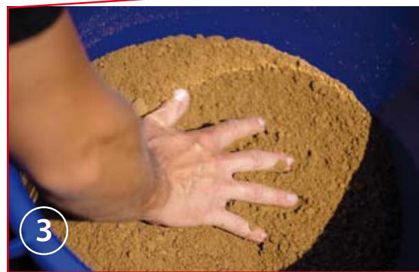
3 Mieszymy całość, w celu połączenia gliny z odpowiednią ilością wody
